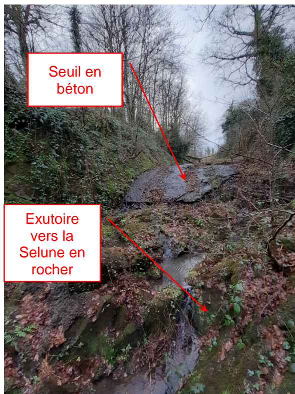
Figure 5 : extrémité aval du canal évacuateur (février 2024)
